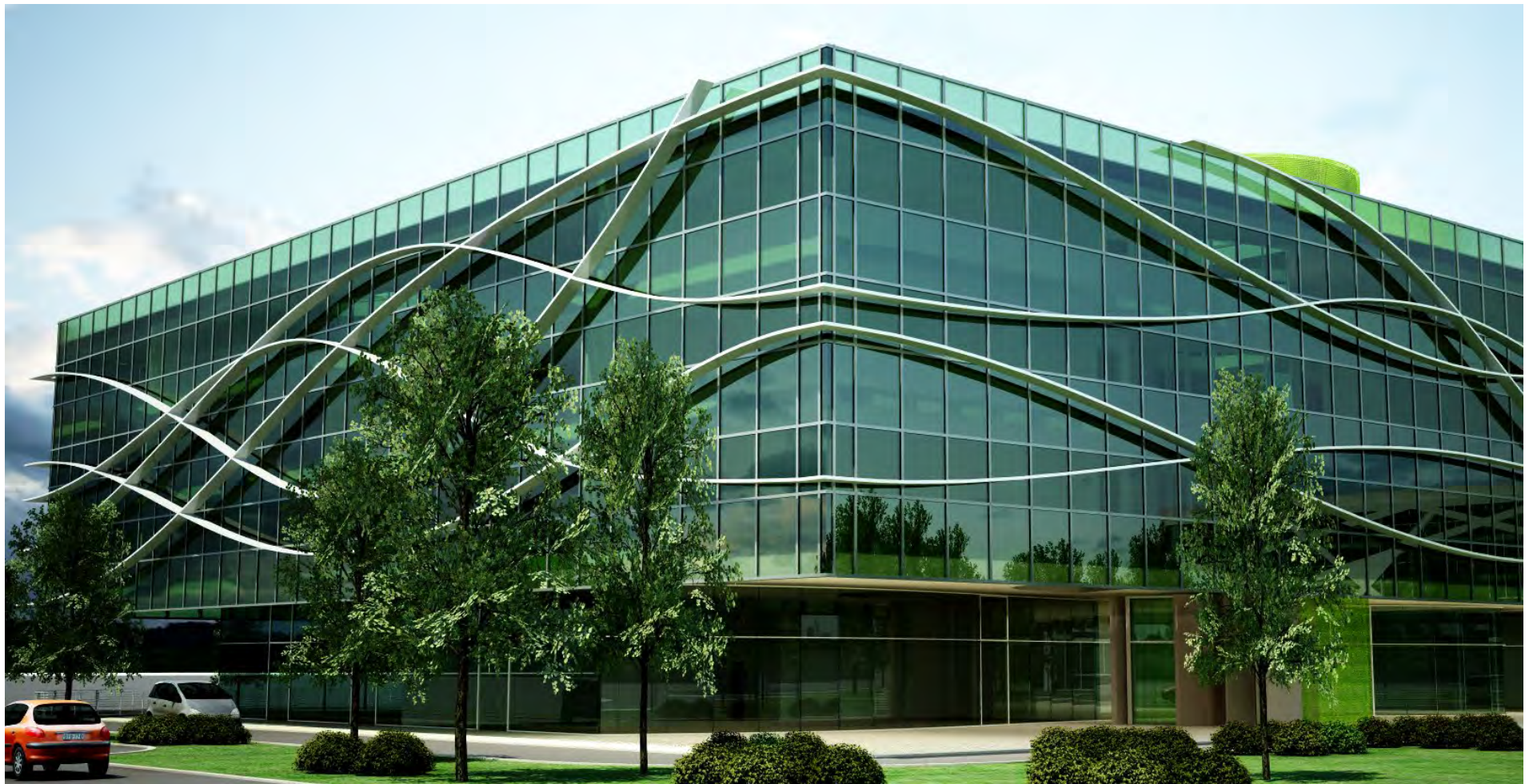
PESCARA – La City Business Center (Studio SDAA, in corso) Progetto esecutivo, project management, relazioni di calcolo delle facciate continue esterne pluripiano caratterizzate dall' inserimento di sistema speciale di frangisole curvilineo aggettante.
