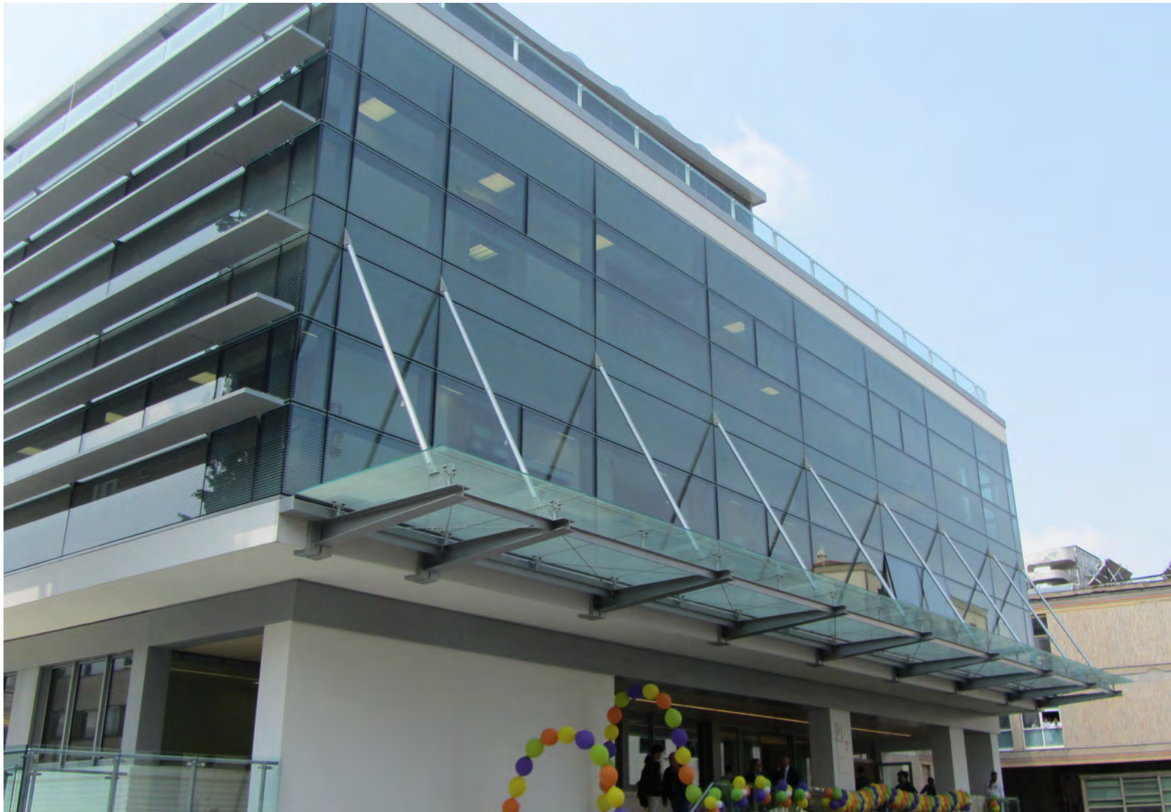
FIRENZE – Polo Materno – Infantile Careggi (Binini Partners srl, 2012) Assistenza alla realizzazione del progetto di variante e Direzione Lavori, analisi e verifica dei Mock-Up e documentazione di certificazione dei produttori, controllo della qualità delle fasi di posa.
