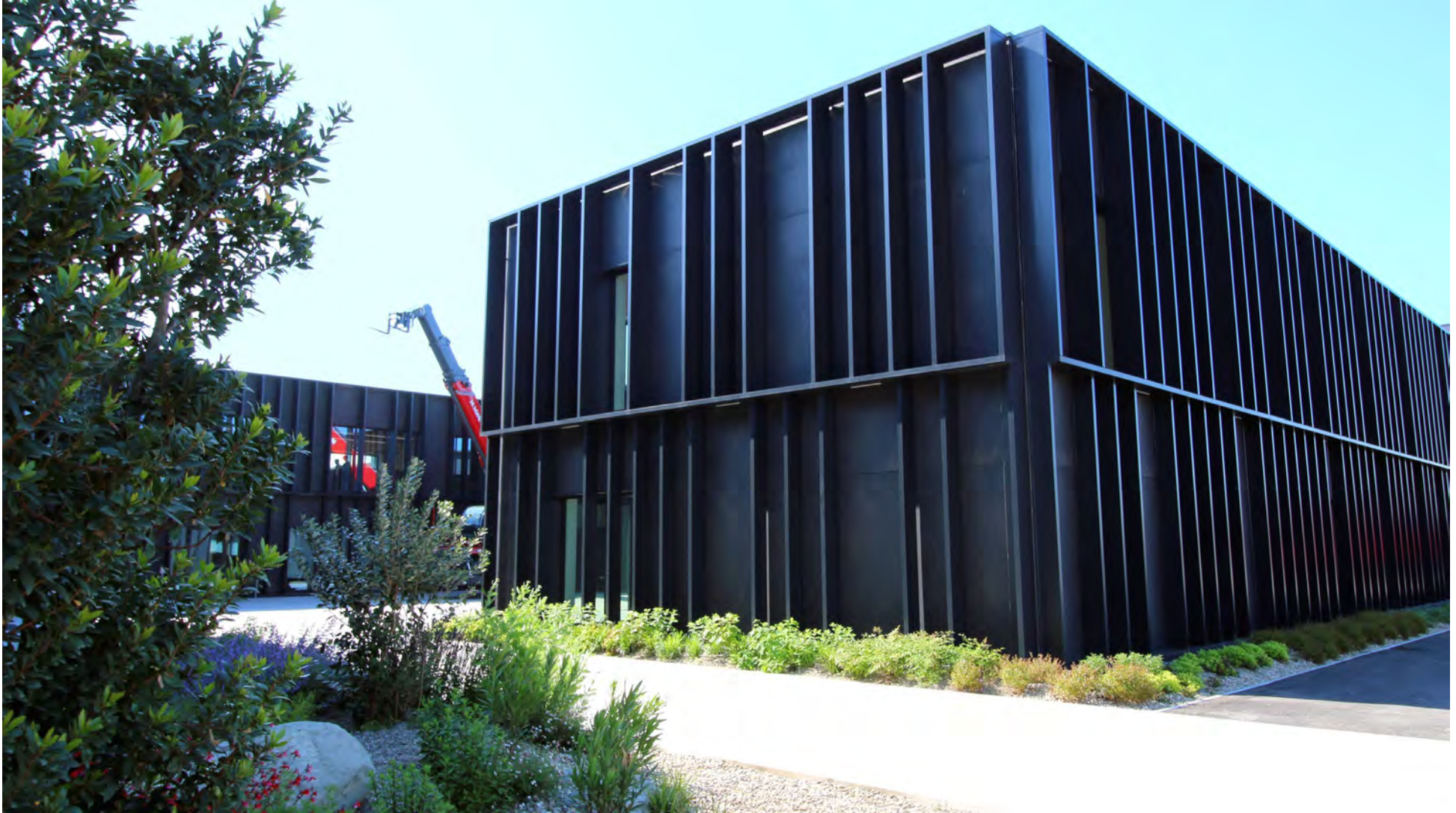
CASTELFRANCO EMILIA (MO) – Headquarter Magni Telescopic Handlers Esecuzione del progetto esecutivo e dei dettagli costruttivi con calcoli statici delle facciate ventilate realizzate in rivestimento ceramico di grandi dimensioni riquadrate da frangisole a sezione tubolare, di massime prestazioni energetiche e acustiche con impiego di materiali specifici per il rispetto della ecosostenibilità ambientale.
