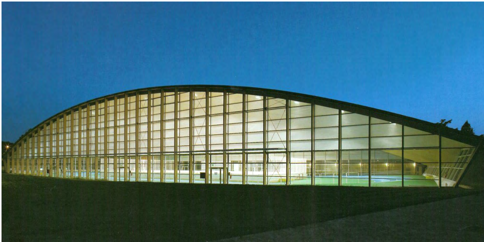
PARMA – Palestra Polivalente (arch. Contini Marco, 2007) Consulenza per la progettazione di facciata continua in alluminio a forma semiellittica di altezza massima pari a 13m. Studio di sistema di ombreggiatura realizzato mediante l'applicazione di speciali tessuti traslucidi inseriti all'interno dei vetri camera di facciata. Dimensionamento statico della facciata e studio di dettagli; valutazione con calcolo di alternativa alle strutture portanti in acciaio.
