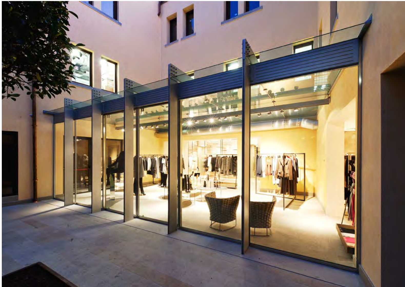
MESTRE (VE) – Negozio Max-Mara (Arch Duccio Grassi, 2011) Struttura in vetro e acciaio posta nel cortile interno del negozio Max Mara a Mestre caratterizzata da una copertura piana e da una facciata verticale di raccordo tra pavimento e il lato libero della copertura. L'incarico prevedeva l'ingegnerizzazione delle soluzioni tecniche, l'elaborazione di disegni esecutivi e produttivi, relazione di calcolo delle travi in acciaio, dei vetri più critici e dei supporti più sollecitati, istruzioni di posa e capitolato specifico.
