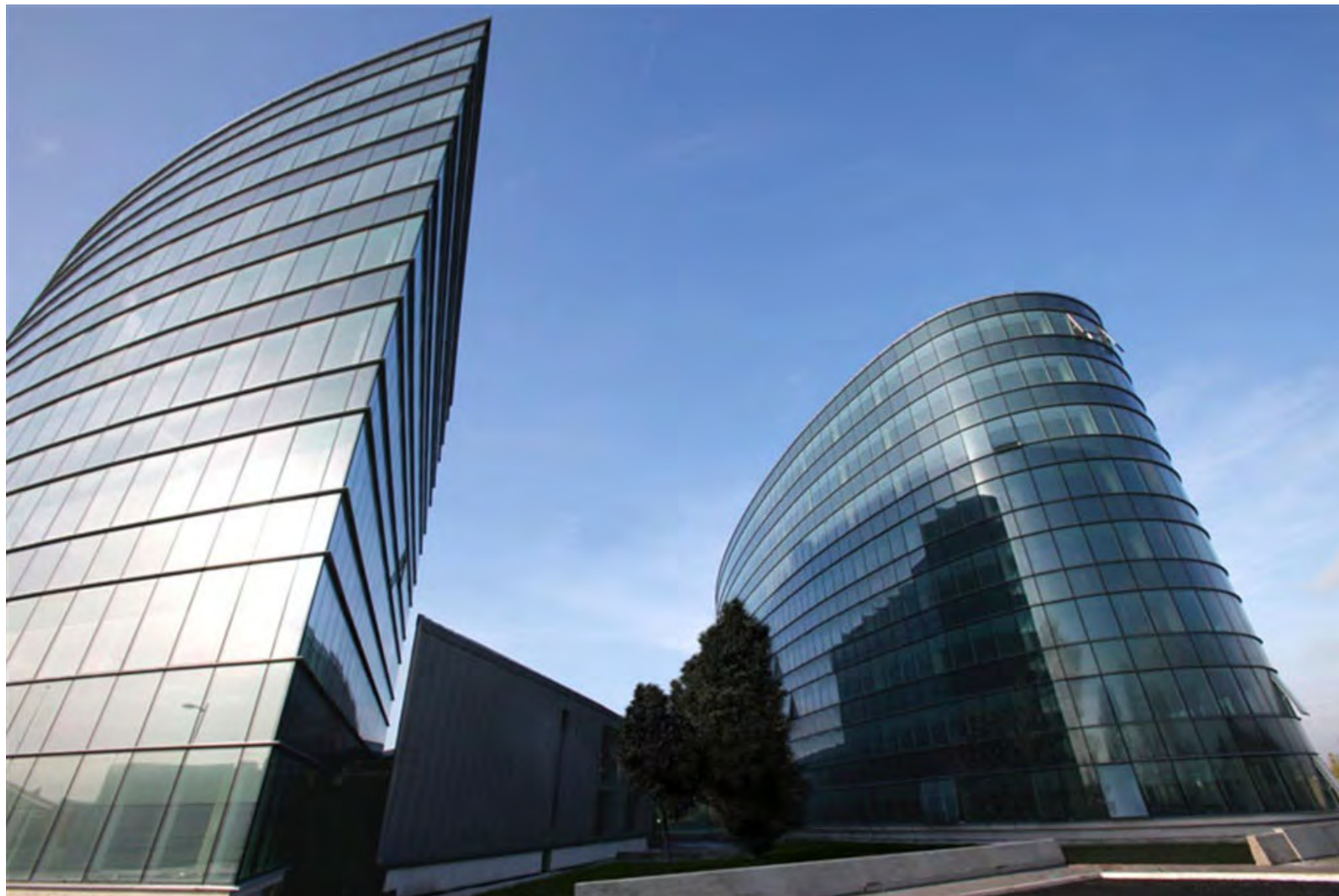
ROMA – Da Vinci Business Center (INGENIUM RE srl, arch. Marco Tamino, 2011) Assistenza al Project Management, progetto esecutivo, calcoli e progetto costruttivo del corpo C - impresa IMAR- PE.
