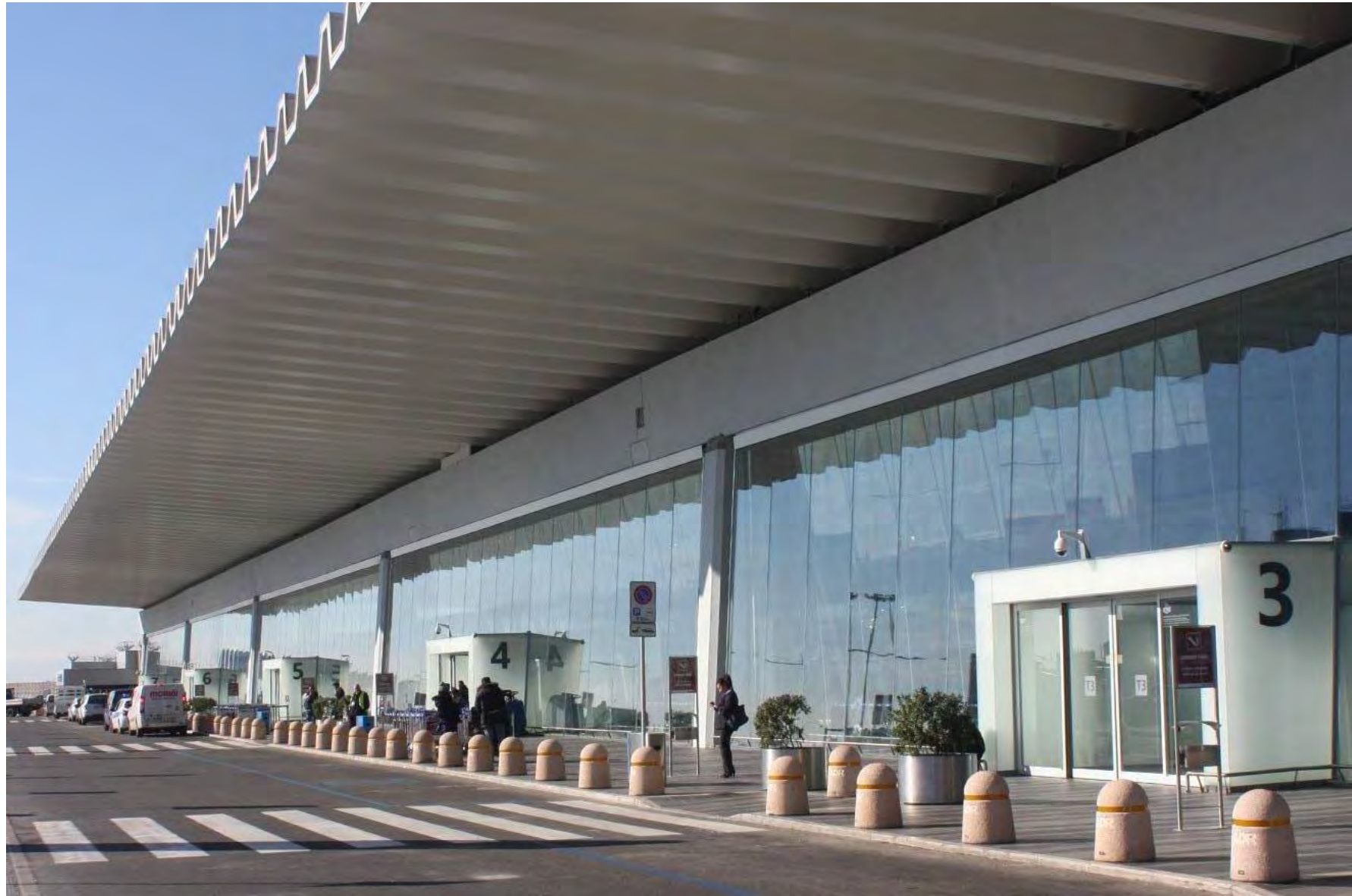
ROMA – Terminal T3 Aeroporto Fiumicino – (Mario Bellini architects) Ristrutturazione con realizzazione di facciate a doppie pareti in vetro contrapposte e inclinate, di altezza 7metri, con inserite bussole di accesso in vetro semiopache e retroilluminate
