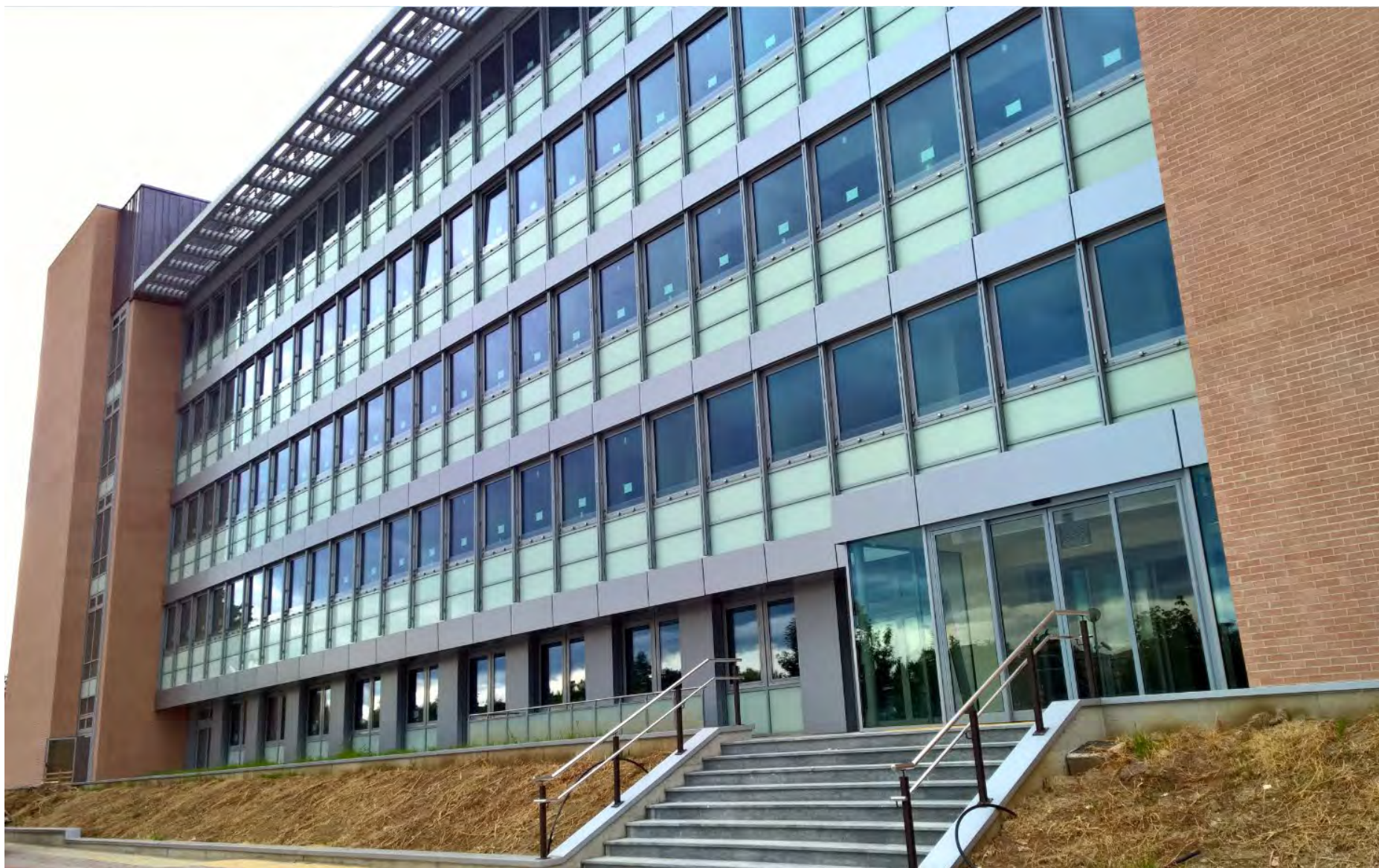
REGGIO EMILIA – CORE ospedale oncoematologico (Arch. Binini Partners srl, 2014) Attività di consulenza specialistica con analisi documentale e proposte migliorie, per quanto riguarda il lotto facciate dell'ospedale.
