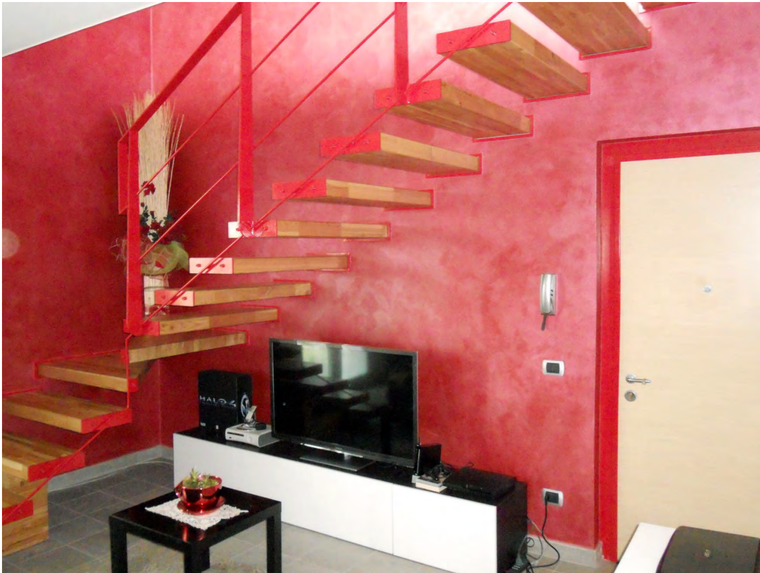
BAGNOLO IN PIANO – Scala interna casa Cattivelli (Studio Cattivelli, 2011) Progetto completo e calcolo statico della scala interna alla abitazione Cattivelli. Il cosciale di rinforzo della parete è rivestito in cartongesso per nascondere completamente le strutture portanti e gli elementi di fissaggio dei gradini in legno uscenti a sbalzo dal muro. Lame sagomate in acciaio fissate sulla testata del gradino sorreggono parapetto e corrimano.
