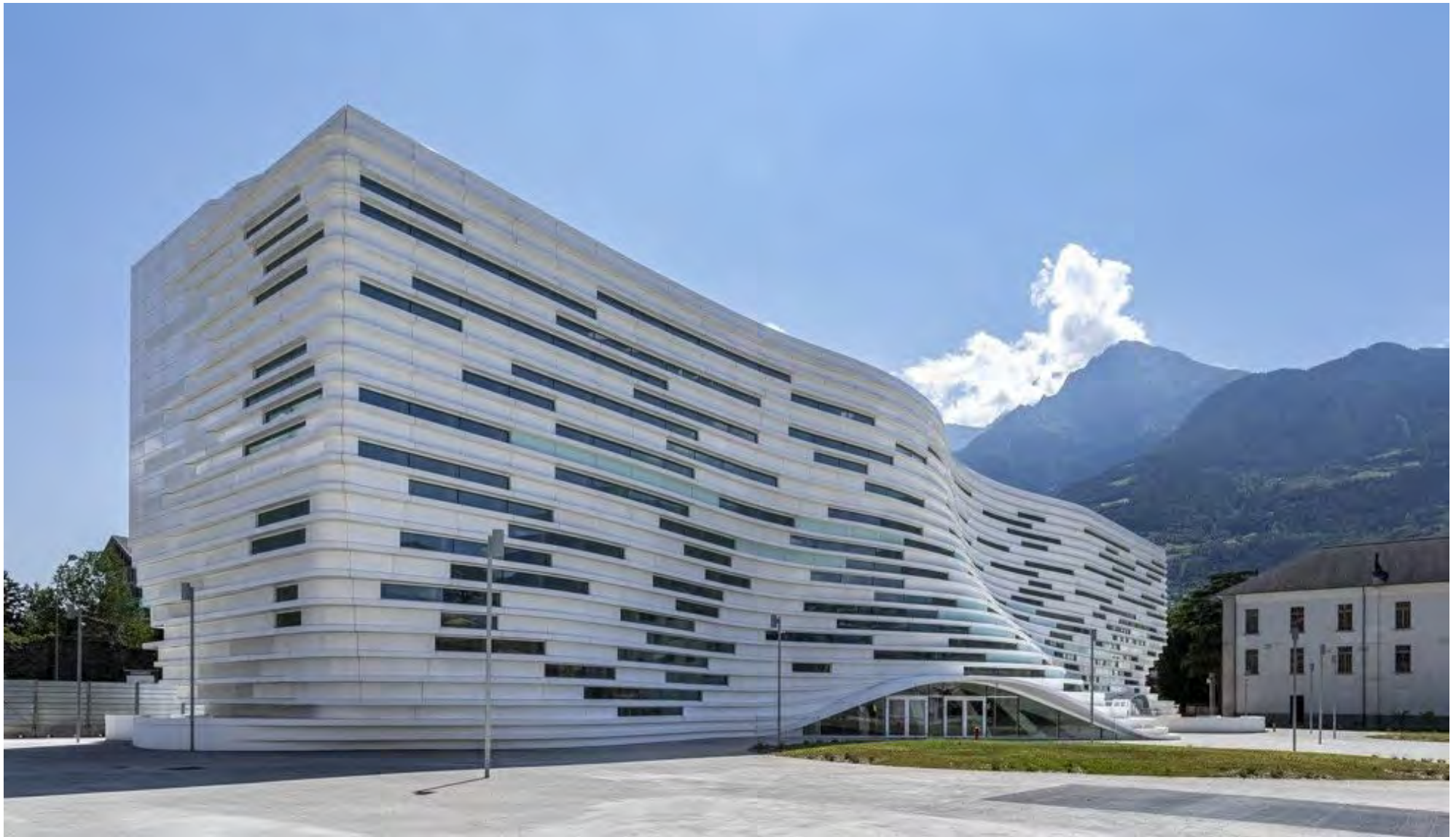
AOSTA – Nuova sede Universitaria – (MCArchitects) Progetto costruttivo. La facciata a tutta altezza che racchiude la grande hall dell'edificio è costituita da una struttura portante in "centine" d'acciaio sagomate, a sostegno di un rivestimento realizzato da cassoni orizzontali in termoplastico e tamponamenti verticali in pannelli di lamiera isolati e vetri-camera inseriti in guide a taglio termico
