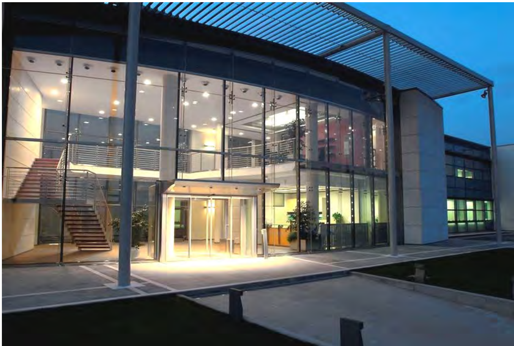
TREVISO – Sede OGP (Ing. Giuliano Magnoler, 2003) doppia pelle a pianta curva, basata sul principio del risparmio energetico a riciclo di fluidi in stagione sia estiva che invernale; pelle esterna realizzata con travi in vetro e fissaggi a routulles, pelle interna a tutto vetro del tipo a camera isolata, aperture motorizzate del tipo innovativo inserite a scomparsa senza telaio metallico.
