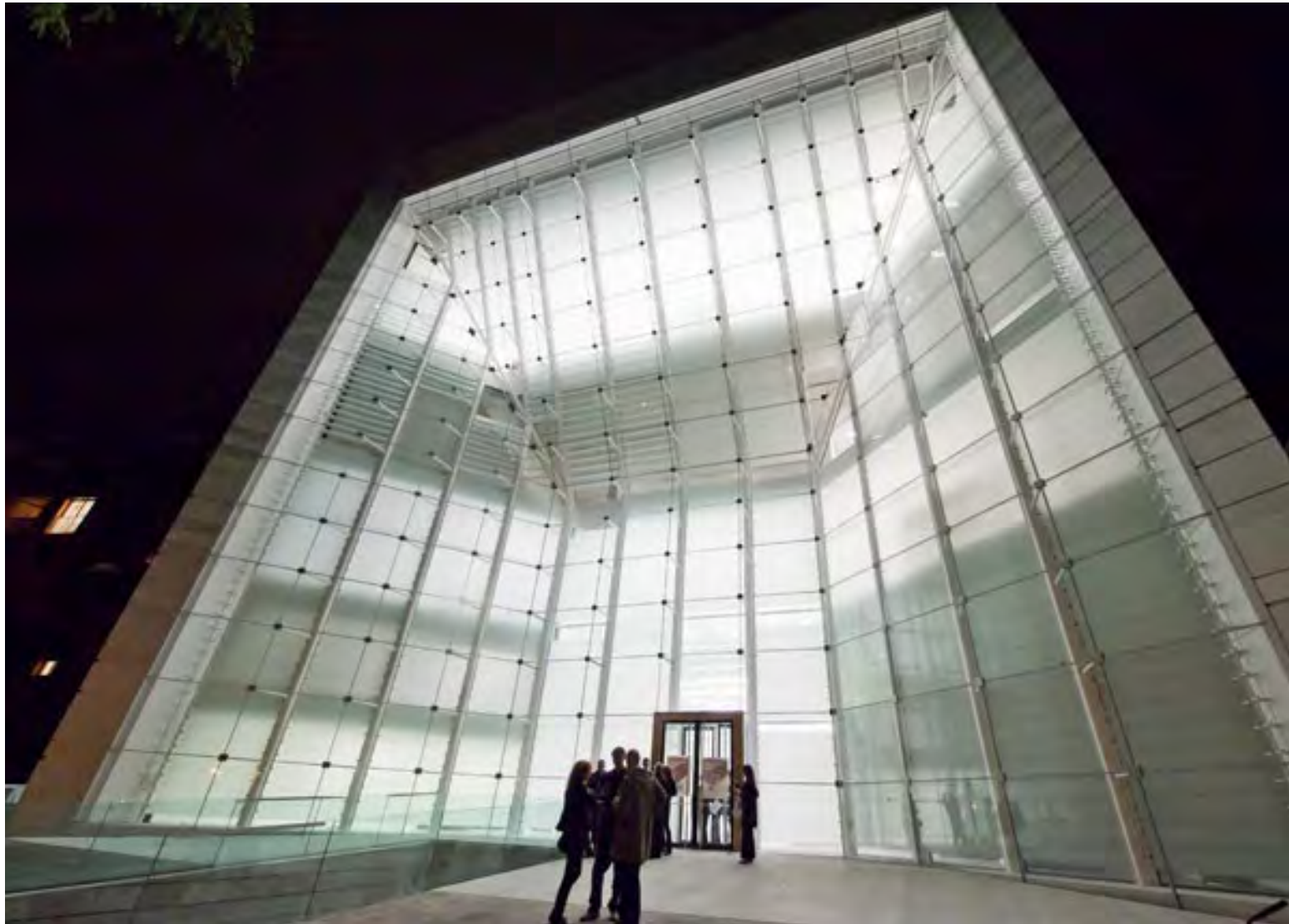
BOLZANO – Museion (Rizzani De Eccher / Vega Systems - arch.studio KSV-Berlino, 2008) Ingegnerizzazione dei sistemi di tensostruttura delle facciate in vetro, calcoli statici FEM ad elementi volumici dei morsetti delle funi e vetri, calcoli a post-rottura dei vetri e dimensionamenti delle lastre ; disegni dei particolari di fabbrica di ogni componente della pelle esterna , con controllo 3d della congruenza spaziale dei vari piani di facciata
