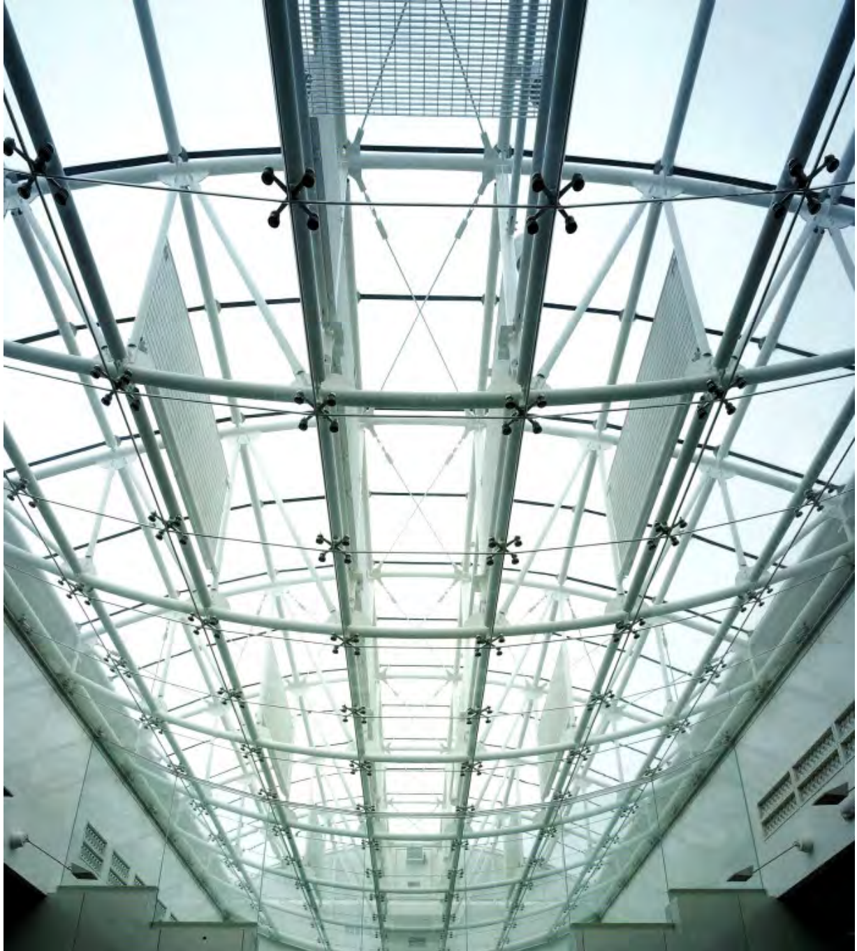
PISTOIA – Stabilimento What's What copertura (Arch. Marcon, 1999 ) Struttura a sezione lenticolare composta da due vetrate contrapposte realizzanti doppia pelle ideata con materiali atti al perfetto mantenimento del confort visivo e termoigrometrico dei sottostanti locali; calcoli statici ed Ingegnerizzazione dei componenti.
