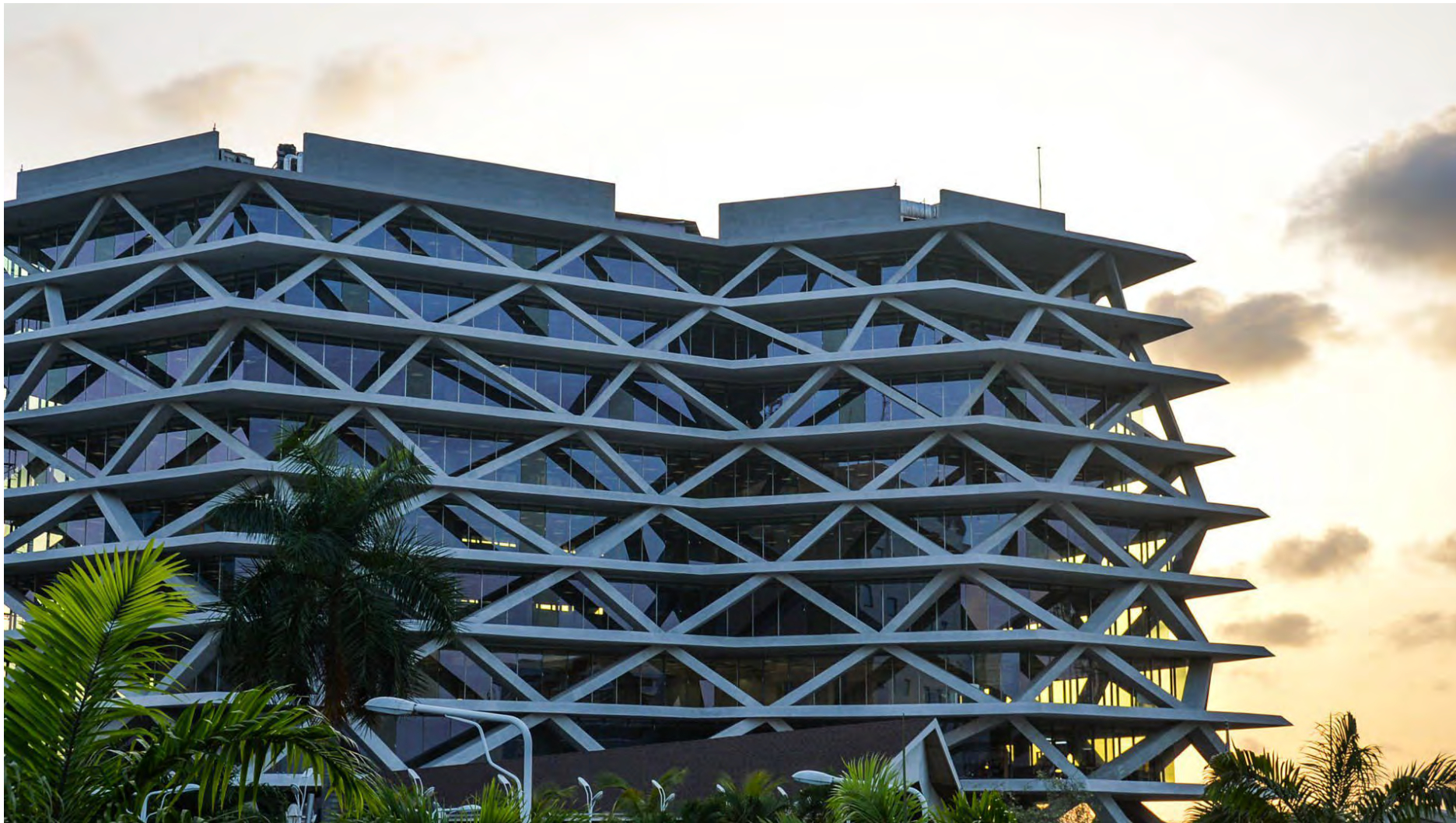
ACCRA (GHANA) – One Airport Square (Arch. Mario Cucinella, 2013) Supporto alla progettazione delle facciate interne ed esterne dell'edificio e della copertura in vetro e alluminio, con scelta dei sistemi e delle tecnologie costruttive
