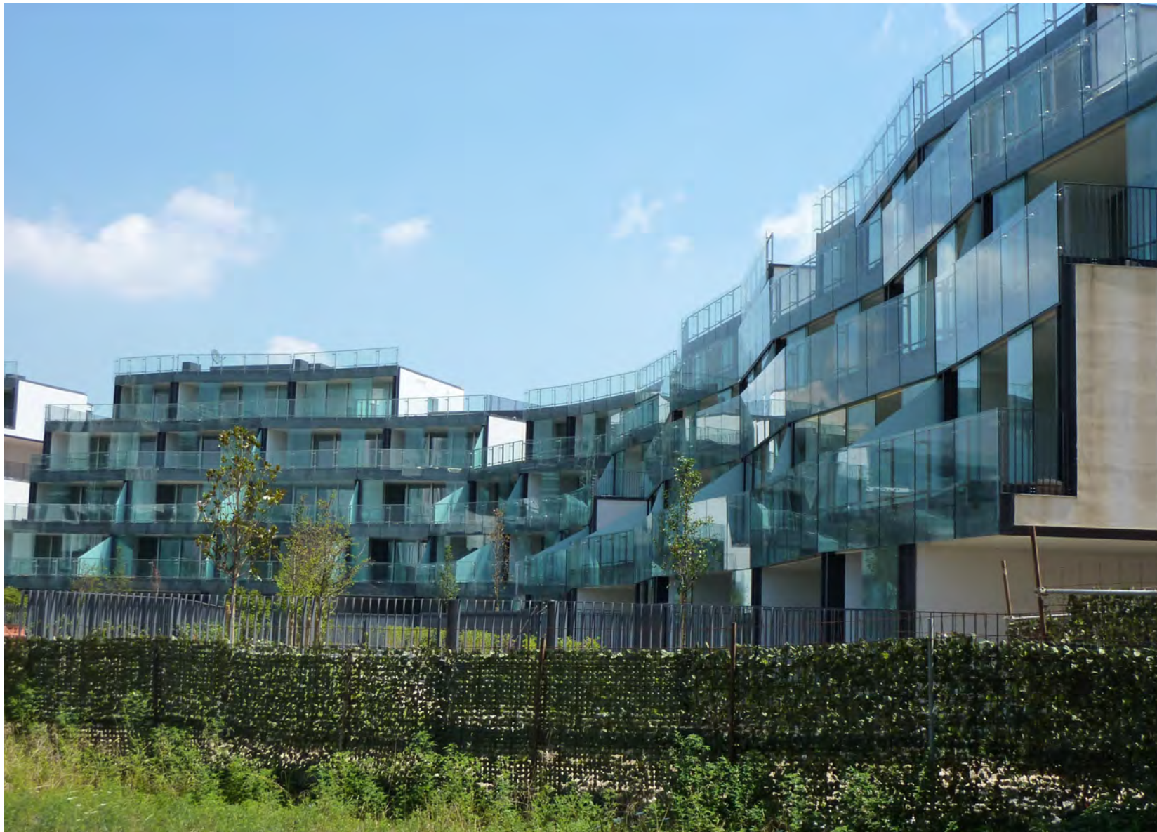
ASSAGO (MI) – Complesso residenziale MilanoFiori (Milanofiori 2000 srl, Studio OBR, 2010) Progetto costruttivo impresa CNS - Milano dei componenti architettonici vetriati scorrevoli a completa trasparenza e chiusura dei giardini a terrazza.
