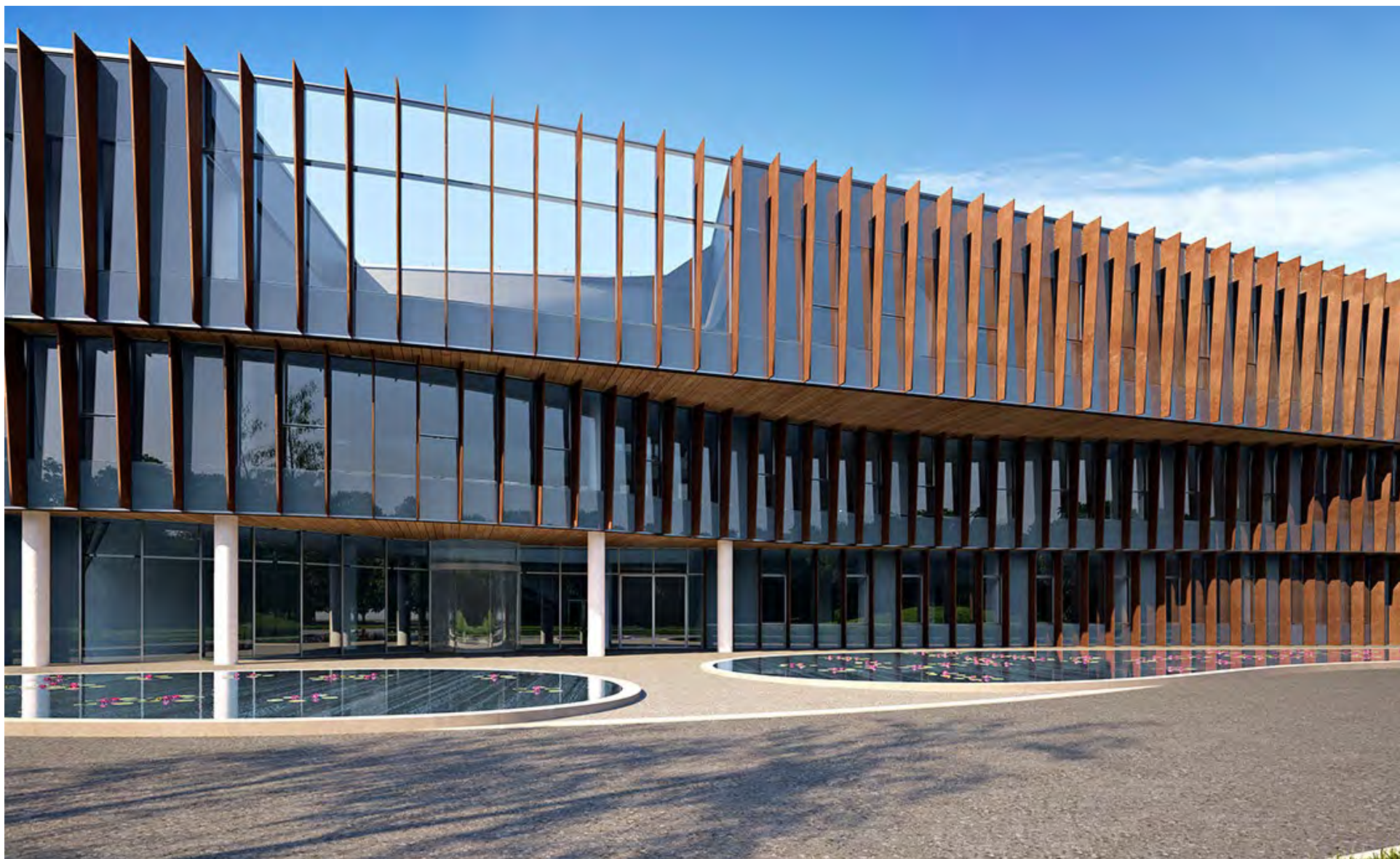
CARPI (MO) – Nuova sede Twin Set (BP Architects, in corso) Progetto esecutivo delle facciate in vetro e alluminio , dei rivestimenti metallici isolanti esterni e delle lame verticali in rame illuminate tramite luci Led con funzione di frangisole oltre che di disegno distintivo architettonico. Supporto per individuazione impresa esecutrice dei lavori e analisi offerte gara d'appalto
