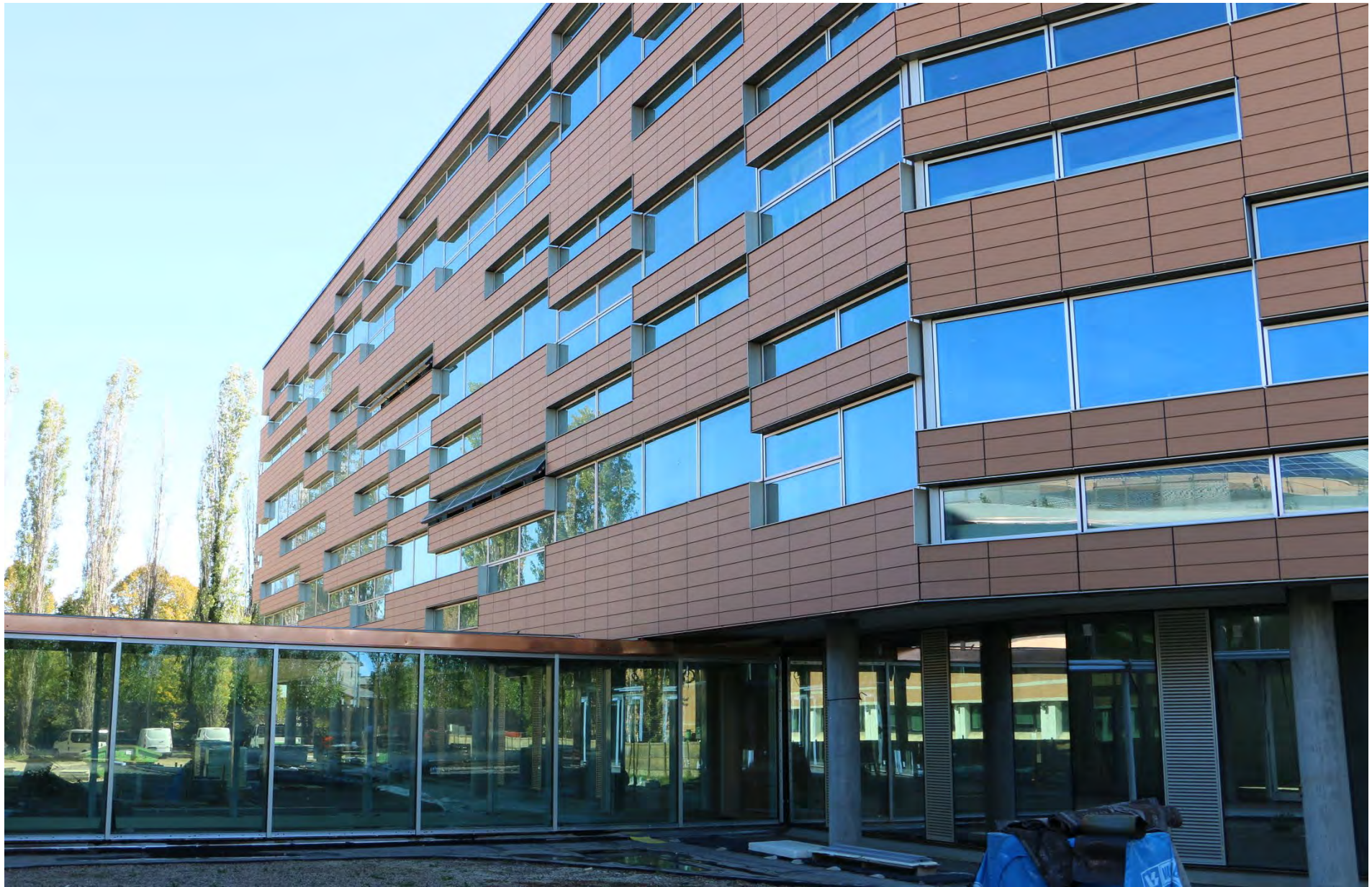
HQ – Crédit Agricole SpA Attività di consulenza specialistica durante le fasi di consolidamento del design criteria, progetto di base e dettaglio. Supporto al servizio ingegneria e supervisione in campo per assistenza specialistica alla DL, presenza ai collaudi prestazionali
