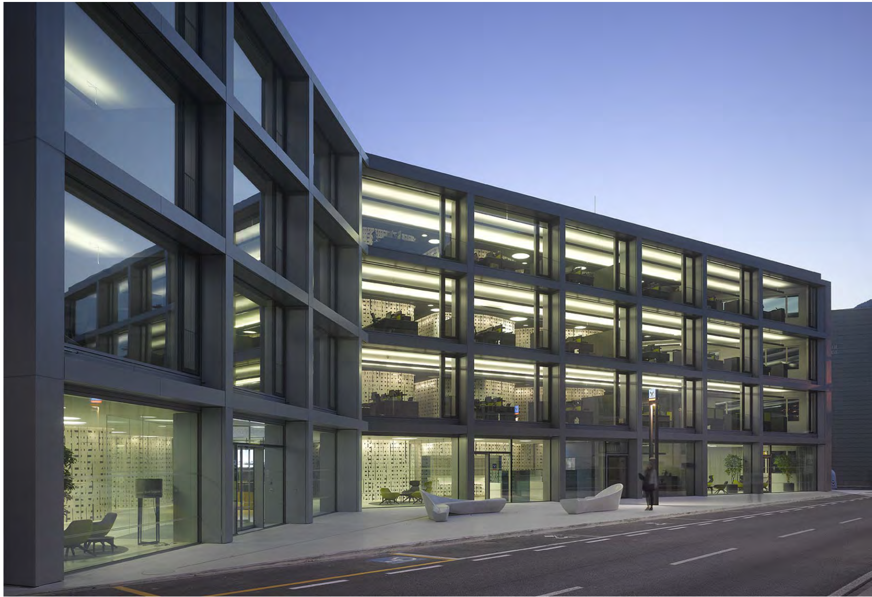
HQ – Banca Popolare dell'Alto Adige Progettazione completa per messa in conformità delle prestazioni termiche, statiche, acustiche, tenute ambientali e adeguamento alle direttive dei VVF per le facciate ventilate ed evacuatori a fumo e calore.
