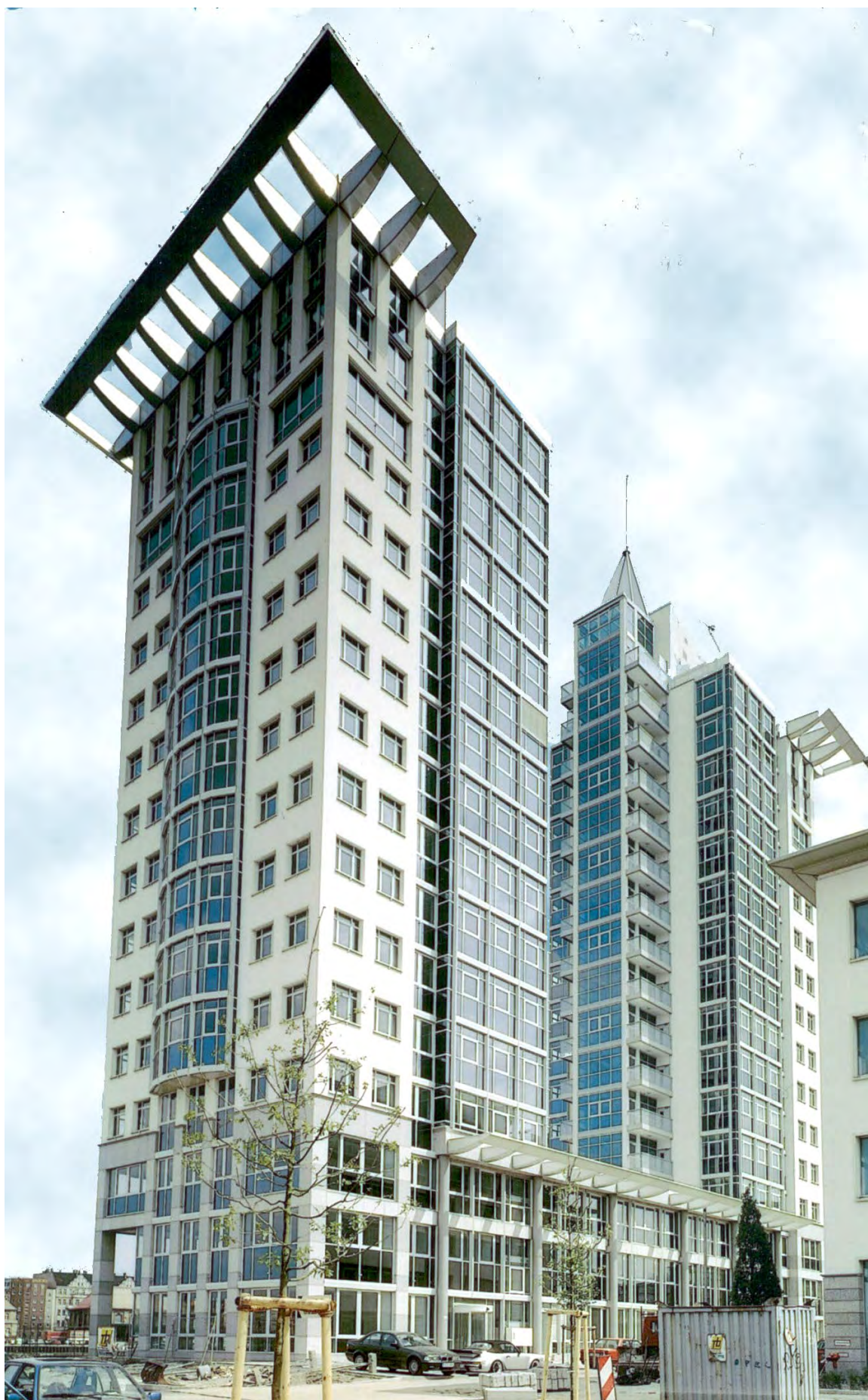
BERLINO – Treptow uffici ed abitazioni (Arch Bilfinger + Berger di Amburgo, 2000) Gestione del progetto e della commessa per tutto il ciclo di produzione e posa di vari sistemi di facciate e rivestimenti per circa 15000 m2 di superficie.
