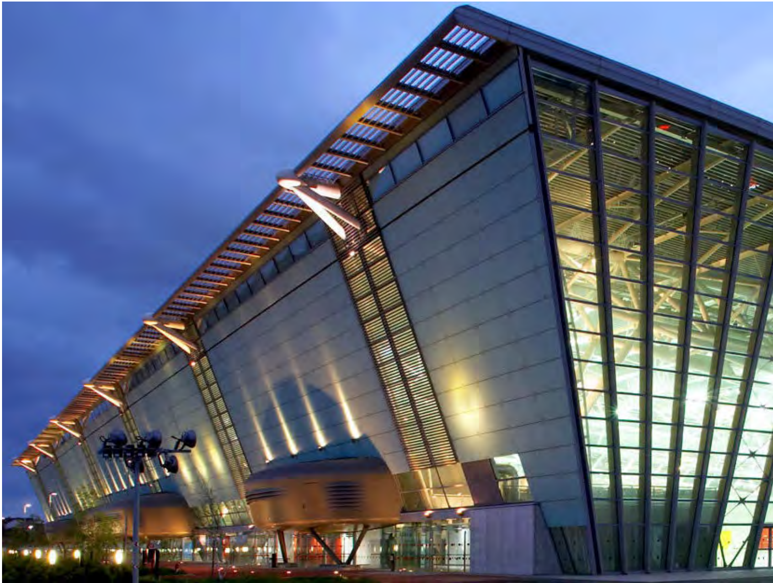
TORINO – PalaOval (arch. Alessandro Zoppini, 2006) Ingegnerizzazione di sistemi di facciate a struttura portante in vetro degli ingressi del Palazzetto di Velocità su ghiaccio, dimensionamento delle vetrate, e controllo qualitativo degli elaborati della facciata inclinata in fase di realizzazione.
