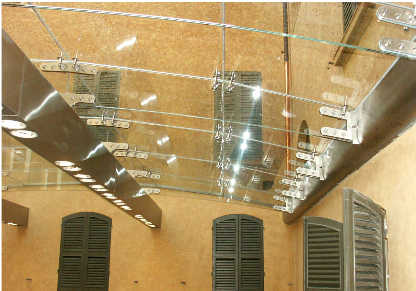
REGGIO EMILIA – Negozio Max-Mara (Arch. Duccio Grassi, 2004) Copertura a botte del cortile del negozio situato nel centro storico cittadino realizzato con travi portanti in vetro a forma arcuata; manto di copertura, in vetro trasparente pedonabile per manutenzione, fissato alle travi sottostanti in vetro tramite snodi affusolati puntuali in inox; calcoli statici della copertura e delle nuove strutture interne del negozio
