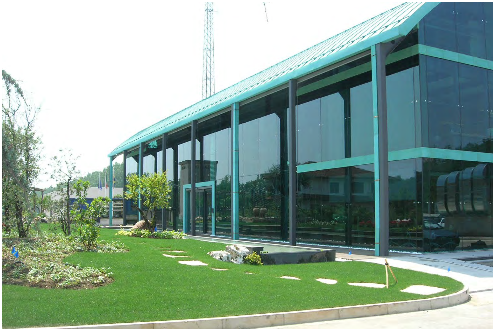
VARESE – Sede ZMC (arch. Riccardo Papa, 2006) Tensostruttura verticale con tralici portanti in funi inox intrecciate poste a supporto del vetro esterno fissato mediante snodi puntuali; la facciata a tutta altezza, posta a chiusura della Hall di ingresso, si prolunga sui lati dell'edificio ove il sistema portante si modifica con diversa struttura a doppie lame in acciaio a sbalzo dai solai sulle cui estremità si fissano le staffe stellate portanti i vetro.
