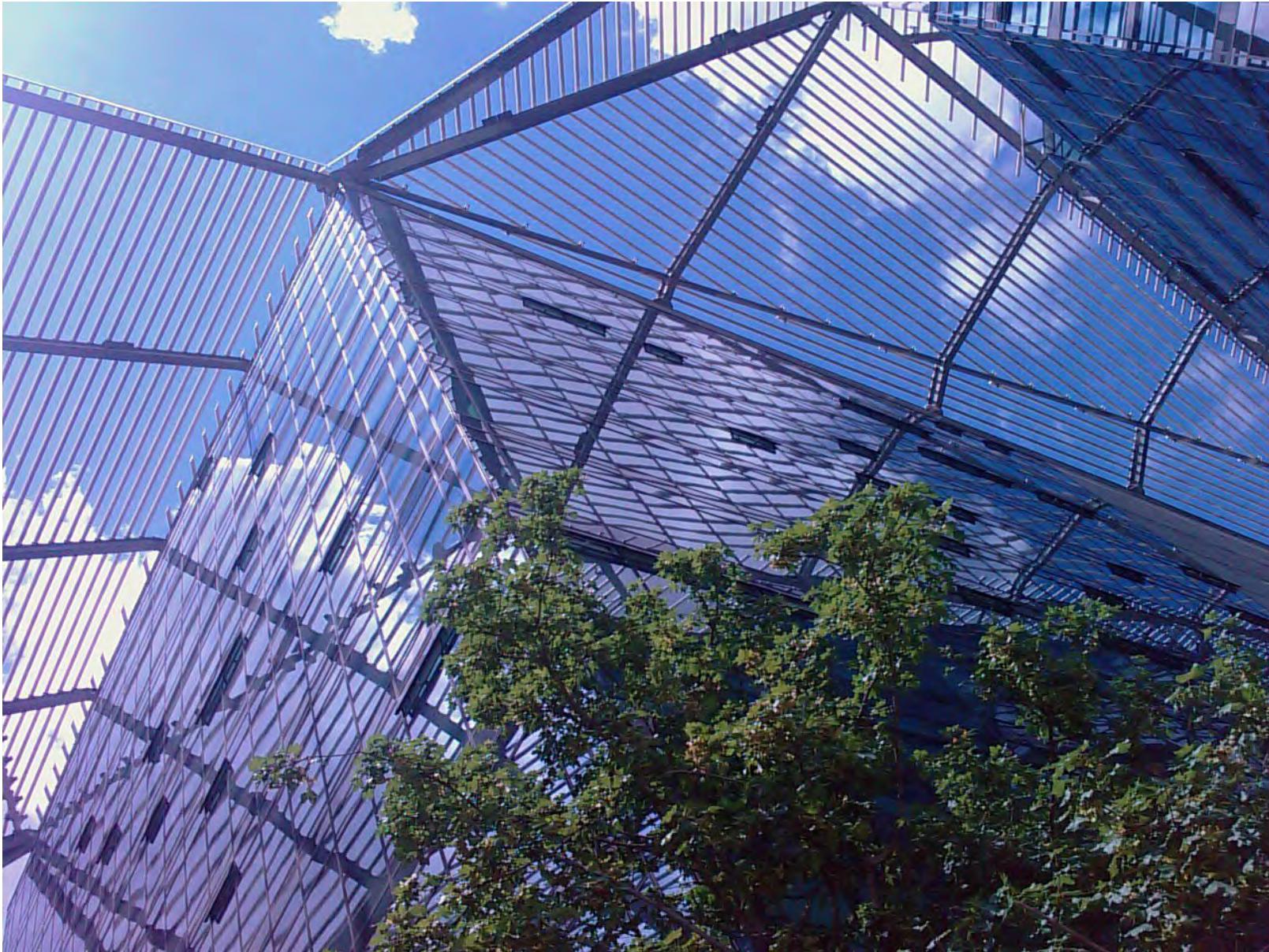
BOLOGNA – Sede unica comune di Bologna - (arch. Mario Cucinella, 2009)
